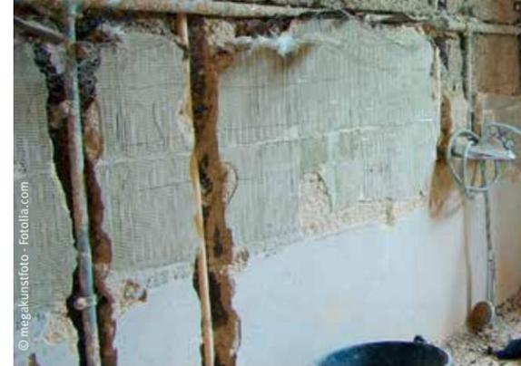
Putze, Spachtelmassen und Fliesenkleber in Altbauten können Asbest enthalten. Stemm- und Schlitzarbeiten an Wänden bergen die Gefahr einer Asbestexposition.
